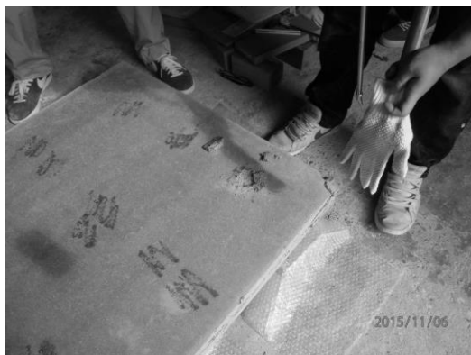
写真13 測定位置の構造確認状況
