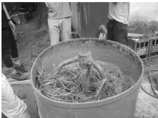
写真9 荒土の調合状況
