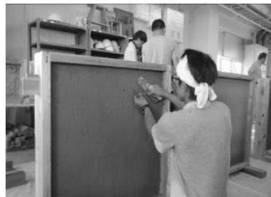
写真6 左官塗り施工状況
