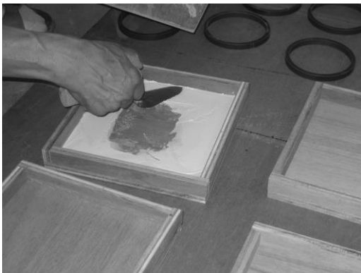
写真 24 熱伝導率試験体の施工状況(1)
