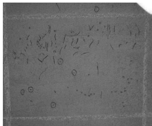
写真 24 ひび割れ測定状況
