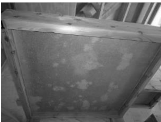
写真 15 900 角試験体 (施工後約 40 日目)
