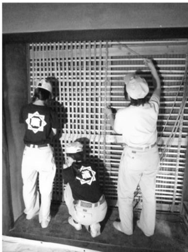
写真 19 木舞建て施工状況
