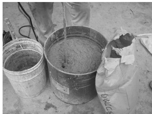
写真10 中塗り土の調合状況
