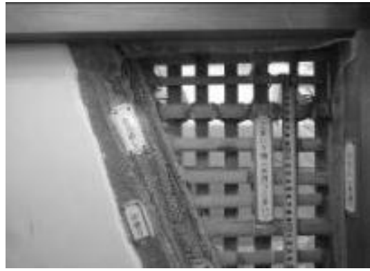
写真2 木舞竹の施工状況
