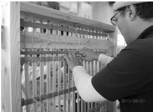
写真3 木舞建て施工状況
