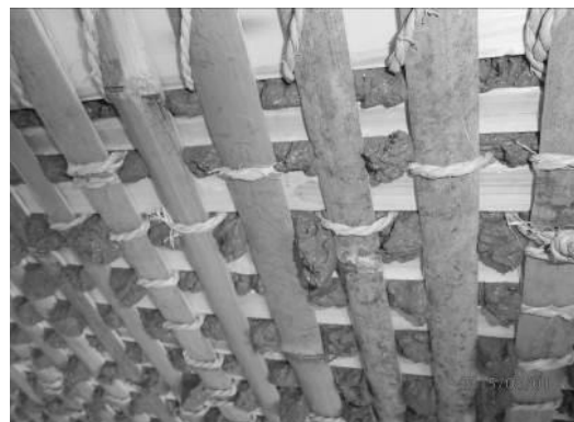
写真5 裏なで前施工状況
