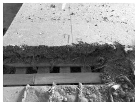
写真14 材料の充填状況
