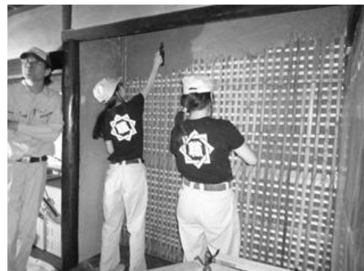
写真 20 荒土塗り施工状況
