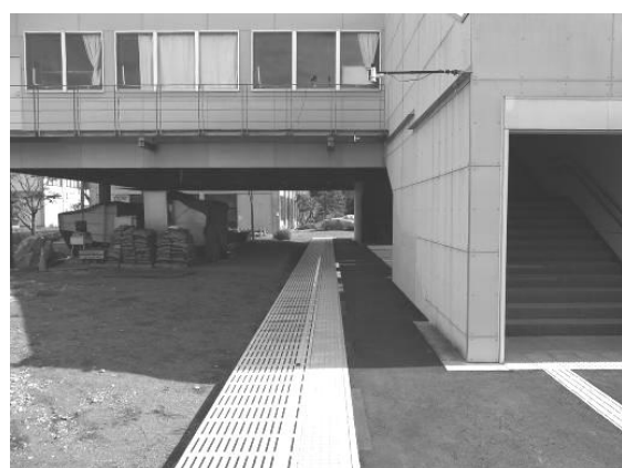
写真 6-2 狭隘部（階段側より）
