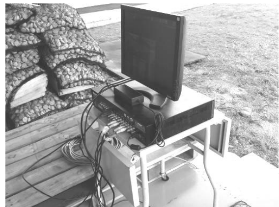
図 6-22 監視モニター・装置
