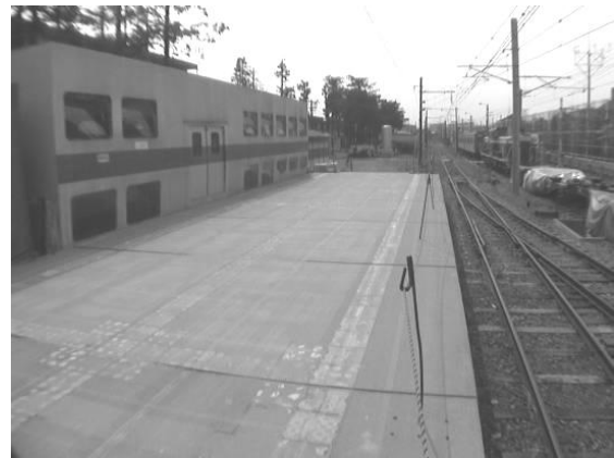
写真 6-25 模擬ホーム (スロープの反対から)
