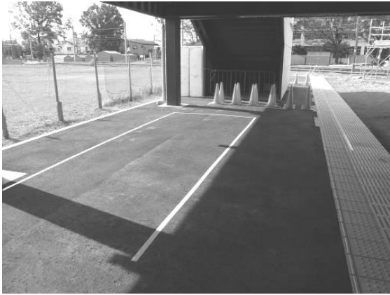
写真 6-3 狭隘部(ホーム側より)
