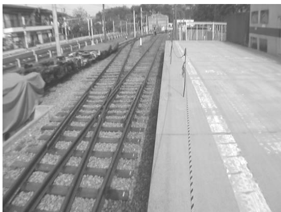
写真 6-26 模擬ホームの端部
