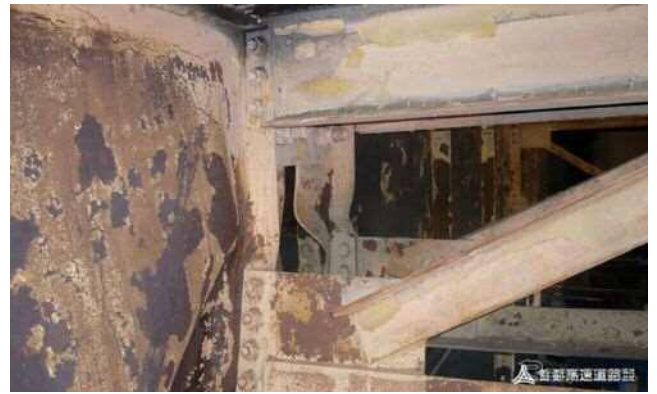
写真-2.2.4 上層主桁の損傷状況（支点部） 2.28), 2.29), 2.31)
