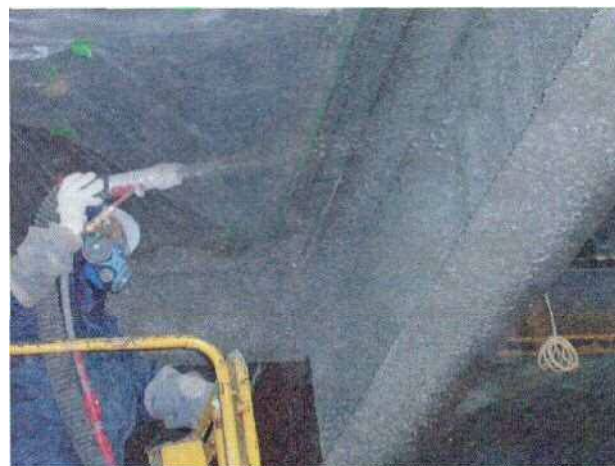
写真-7.3.1 吹付け系の施工状況 7.2)
