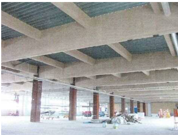
写真-7.3.3 ブランケット（巻付け）系の施工状況 7.4)
