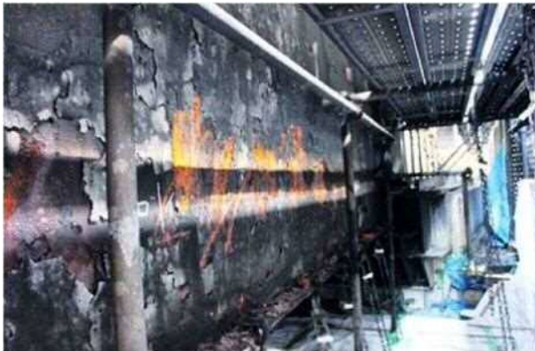
下り線主桁塗装剥がれ（変形無し）
