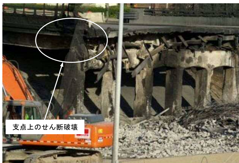
写真-6.5.1 落橋後の支持桁および吊材の状況 6.18)
