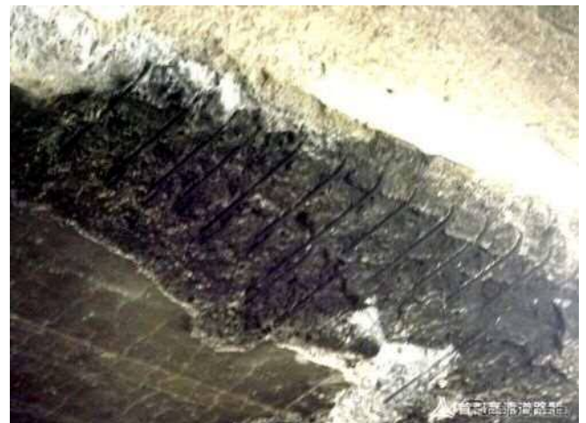
写真-2.2.6 RCラーメン橋脚の損傷状況（池-601橋脚横梁） 2.28), 2.29), 2.31)
