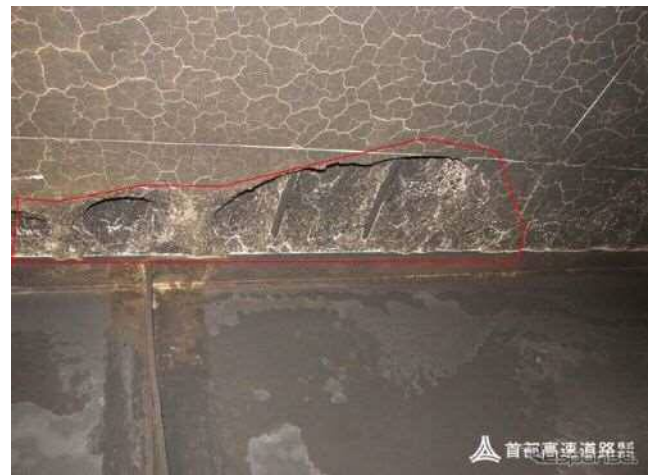
写真-2.2.5 上層床版の損傷状況 2.28), 2.29), 2.31)
