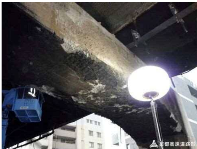
写真-2.2.6 RCラーメン橋脚の損傷状況（池-601橋脚横梁） 2.28), 2.29), 2.31)
