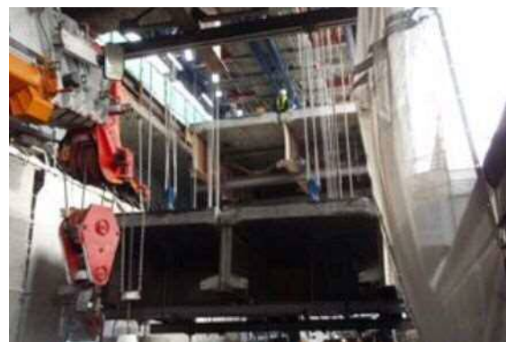
上層主桁・床版撤去（東側）
