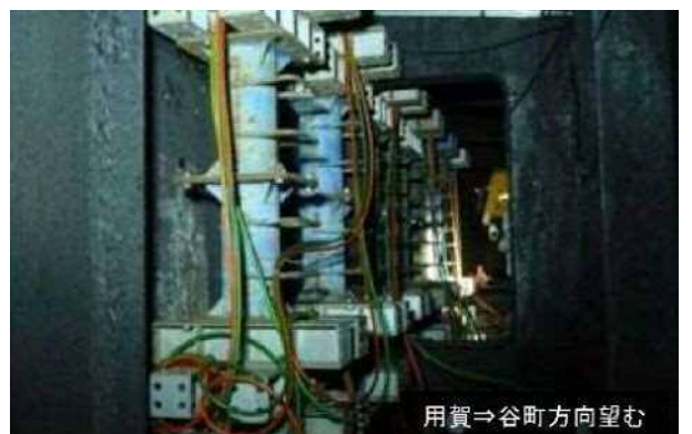
下り線桁内部仮支柱設置（G3）
