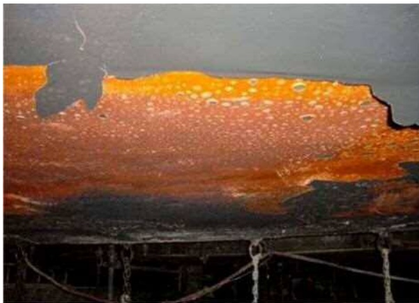
上り線下フランジ塗装剥がれ（変形無し）
