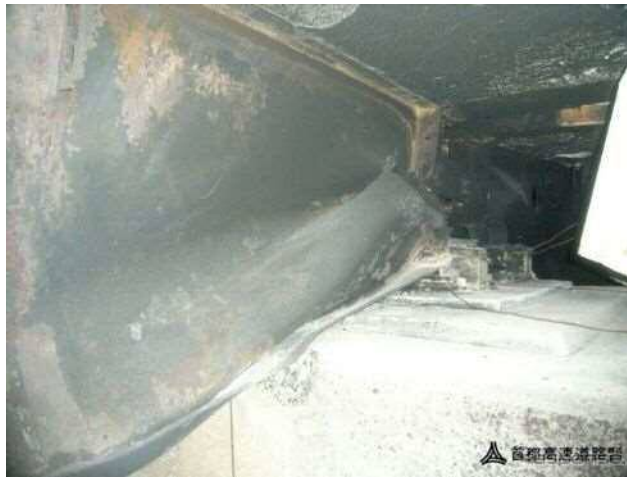
写真-2.2.4 上層主桁の損傷状況（支点部） 2.28), 2.29), 2.31)
