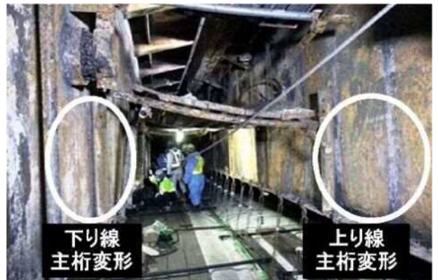
上り線および下り線主桁の変形
