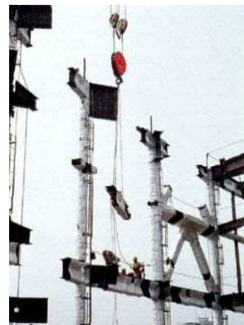
写真-7.3.3 ブランケット（巻付け）系の施工状況 7.4)
