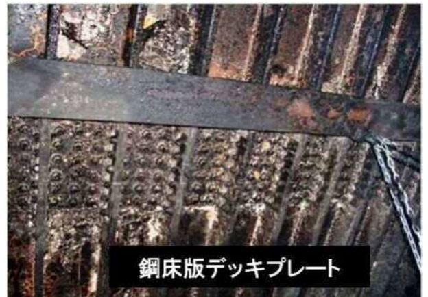
下り線鋼床版ボルト添接部（ボルト緩み無し）
