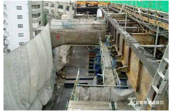
上層主桁・床版撤去完了（西側）
