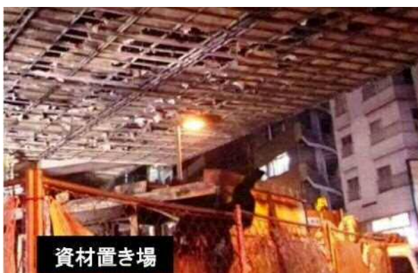
資材置き場直上の仮設足場損傷
