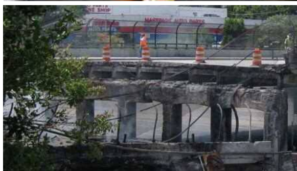
写真-2.2.12 鎮火後および撤去の状況 2.39)
