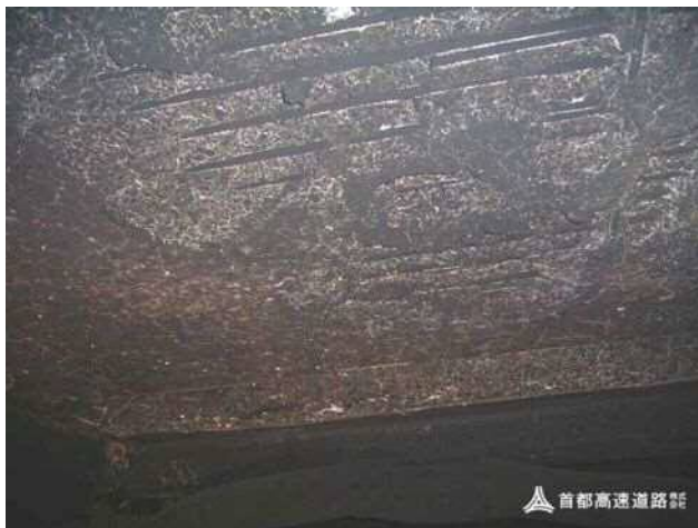
写真-2.2.5 上層床版の損傷状況 2.28), 2.29), 2.31)
