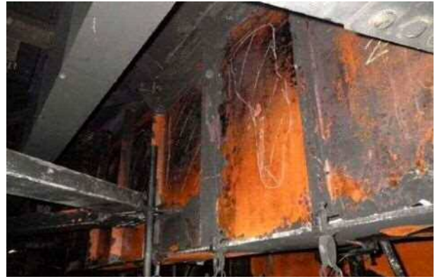
G5桁ウェブ部変形
