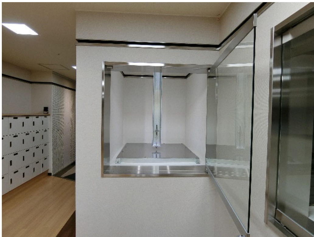
図 5.4 けがき式変位計設置状況
