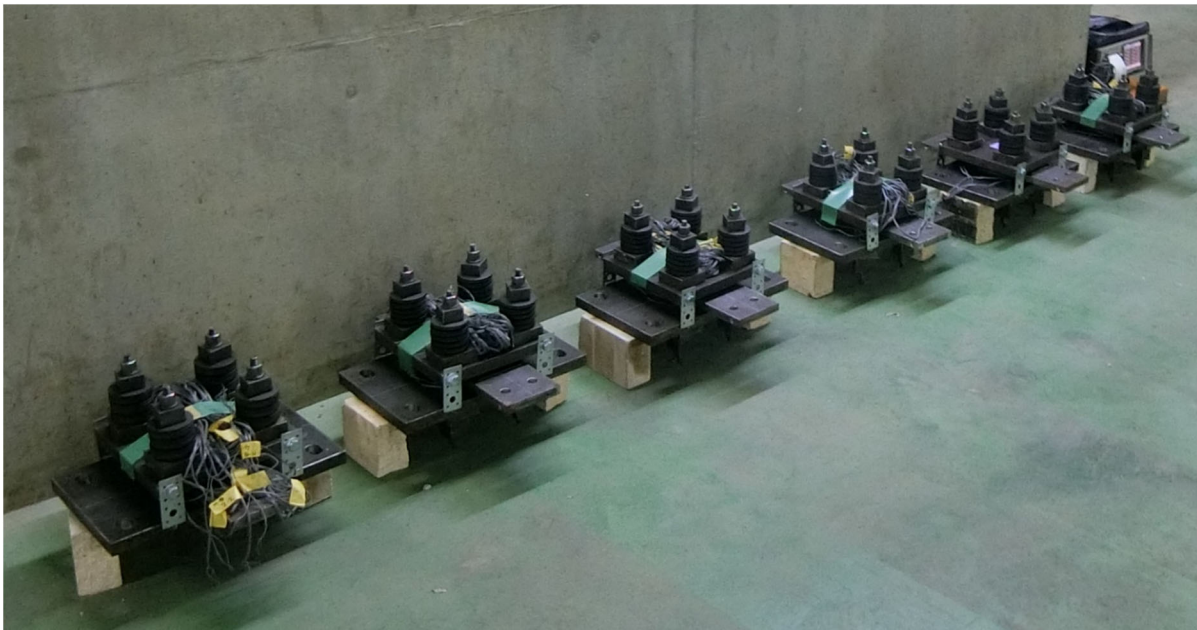
図 3.6 ピット内保管状況
