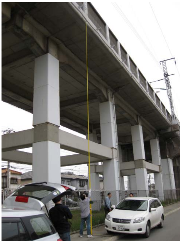
図2. 2. 8 メジャーによる計測風景
