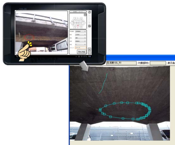
図 2. 6. 3 点検箇所メモ記録
